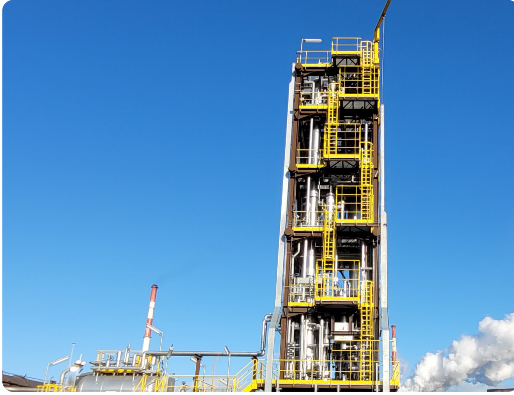
محطة تجريبية لتقنية احتجاز الكربون تابعة لشركة أكسنس ديماكس في مصنع أرسيلور ميتال في دونكيرك، فرنسا. الصورة مقدمة من شركة أكسنس.
