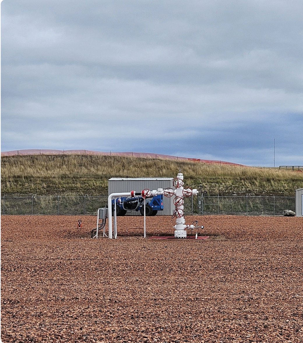
بئر حقن ثاني أكسيد الكربون في موقع احتجاز الكربون التابع لشركة داکوتا غازيفيكيشن بالقرب من مدينة بيولا، في ولاية داکوتا الشمالية. الصورة مقدمة من شركة داکوتا غازيفيكيشن.
