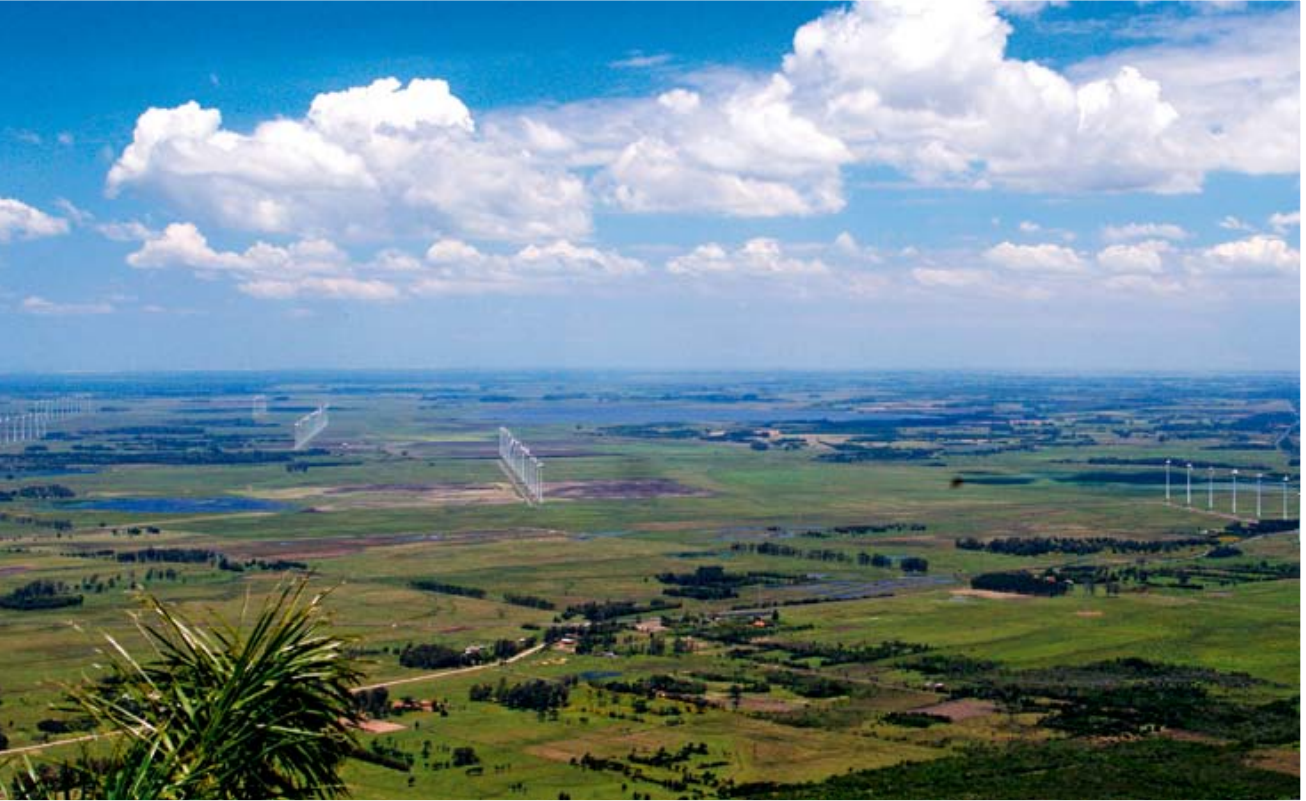
Parques Eólicos en Osorio, Sangradouro and Indios © Wobben
