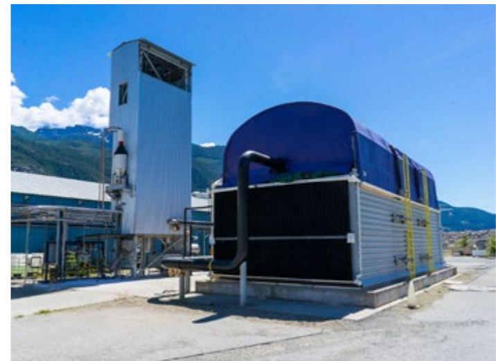
نظام احتجاز ثاني أكسيد الكربون من الهواء مباشرة في المصنع التجريبي التابع لشركة Carbon Engineering. على اليسار تظهر أجهزة ملامسات الهواء والمكلس. الصورة مهداة من شركة Carbon Engineering Ltd.
