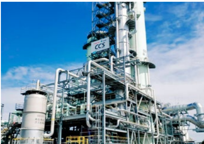
أعلاه: منشأة توماكوامي الإيضاحية لاحتجاز ثاني أكسيد الكربون وتخزينه. الصورة مهداة من الشركة اليابانية لاحتجاز ثاني أكسيد الكربون وتخزينه المحدودة. أعلاه: محطة ميكاوا لتوليد الطاقة. الصورة مهداة من شركة Toshiba Energy Systems & Solutions Corporation (Toshiba ESS).
