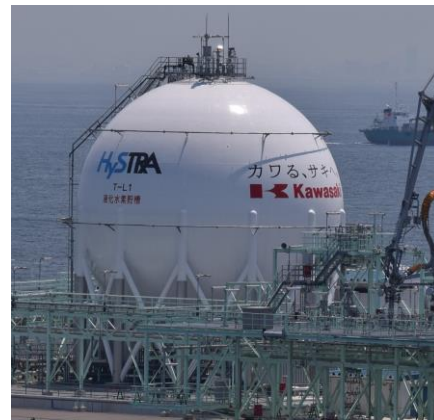
国内最大 液化水素タンク (神戸液化水素荷役ターミナル)
